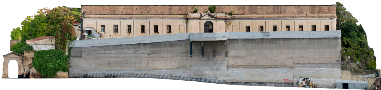
Fig. 5 - Cimitero monumentale delle 366 Fosse. Ortomosaico del prospetto sud | Monumental Cemetery of the 366 Fosse. Orthomosaic of the south elevation
