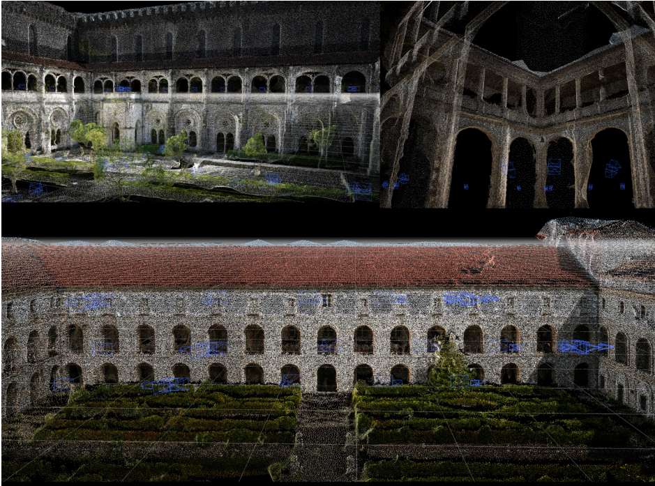
Fig. 5 - Monastero di Santa Maria de Alcobaça: Chiostro D. Dinis o do Silencio (in alto a sinistra), Chiostro dell'Hospedaria (in alto a destra), Chiostro dei Novizi o dei Cardinali (in basso). Nuvole di punti densa, ottenute attraverso il processo di fotogrammetria aerea e l'identificazione dei punti di acquisizione | Monastery of Santa Maria de Alcobaça: Cloister D. Dinis or do Silencio (top left), Cloister of the Hospedaria (top right), Cloister of the Novices or Cardinals (bottom). Dense point clouds obtained through the process of aerial photogrammetry and identification of acquisition points.
