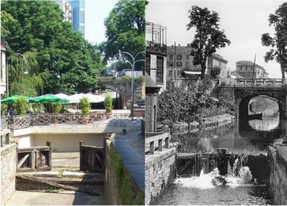
Fig. 3 - L'attuale (a sinistra) e la vecchia (a destra) Conca dell'Incoronata, un segmento della Cerchia dei Navigli. Fonte: Banfi, 2021 | The current (on the left) and the old (on the right) Conca dell'Incoronata, a segment of the Cerchia dei Navigli. Source: Banfi, 2021.
