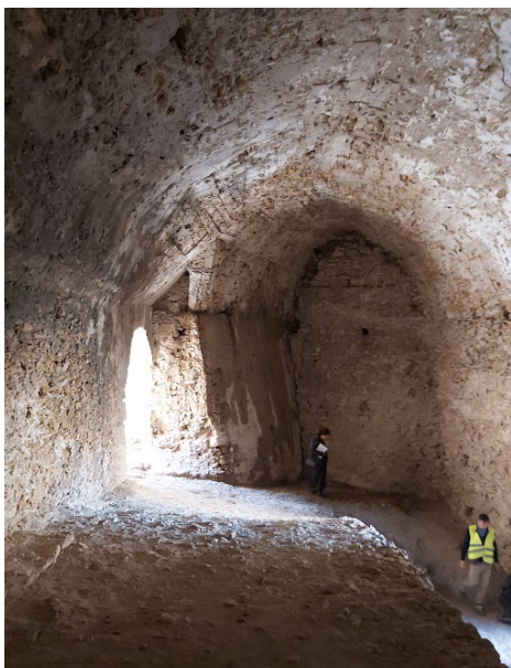
Fig. 2- Interno del bastione San Giacomo del Castello. In fondo a sinistra parte del torrionetto (T. Tedesco, 2023).
