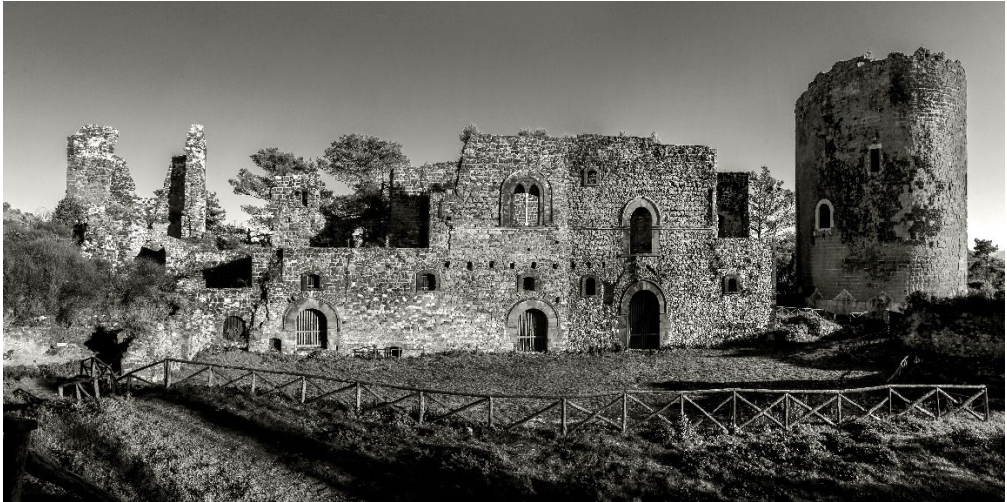
Fig. 7- Il castello di Casertavecchia allo stato attuale (Bruno Cristillo, 2024).
