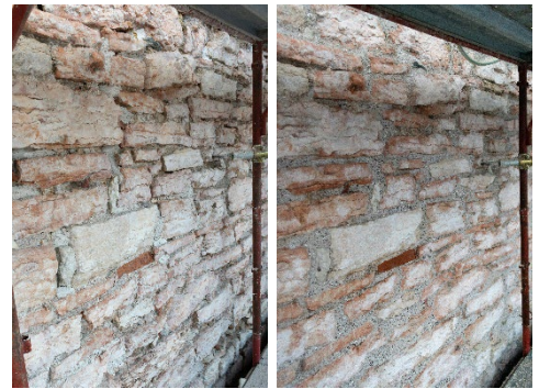
Fig. 11- Porzione di muratura prima e dopo l'intervento di restauro (M. Mazzocchi, 2023).
