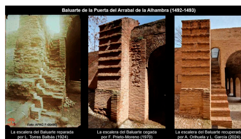
Fig. 5- Proceso de recuperación de la escalera original del baluarte, 1924-1970-2024 (APAG/F-00495 y A. Orihuela).
