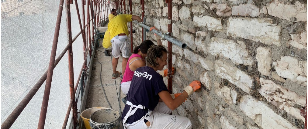
Fig. 9- Stesura della malta di progetto ad integrazione delle malte decoese (Giorgia Gentilini, 2023).
