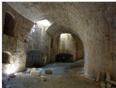
Fig. 6 -Interno del forte S. Nicolo, Sebenico (foto di Dragos Cosmescu, 2024).
