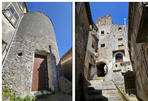
Fig. 5- Torre semicircolare e porta del Salvatore con torre.
