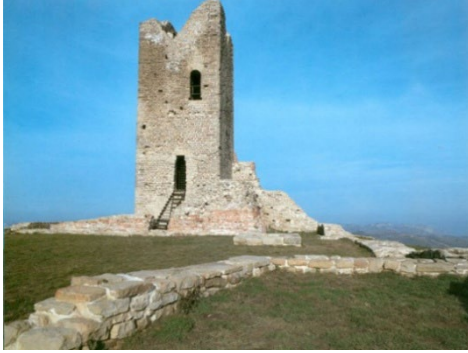
Fig. 9– Restauro del torrione (archivio Studio Rava-Piersanti).
