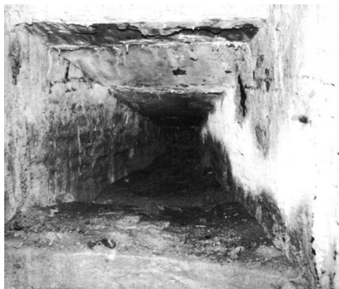
Fig. 12- Puntone Santa Maria Maddalena: bocca di volata a quota - 4.70 con ancora intatti il gradino e il legno di appoggio per una piccola artiglieria (Archivio Taddei, 1997).
