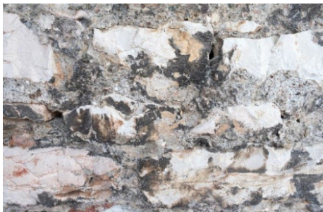
Fig. 4- Dettaglio delle incrostazioni carboniose (M. Mazzocchi, 2023).
