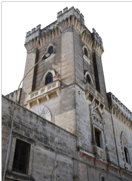
Fig. 5- Torre del castello di Monteparano (Chiamamaria Spinelli, 2024).
