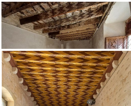
Fig. 6- Arriba : Forjado de madera sin restaurar en el piso superior. Abajo: Forjado de madera restaurado en el ala oeste de la planta noble (Concepción López, 2024).
