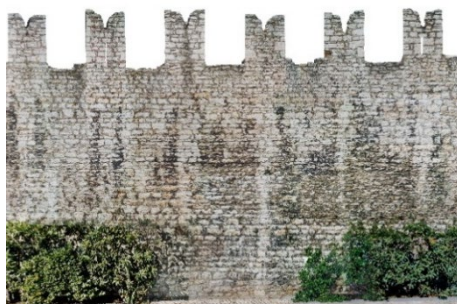
Fig. 2- Ingrandimento di una porzione di fotopiano - lato sud. Settore B. (rilievo di S. Franceschi, A. M. Lazzari, 2005).
