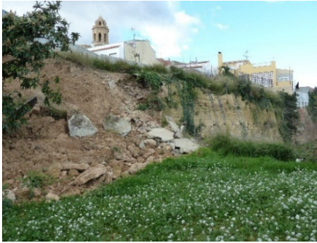
Fig. 15- Desprendimiento (Fotografía de Arturo Zaragoza, 2012).
