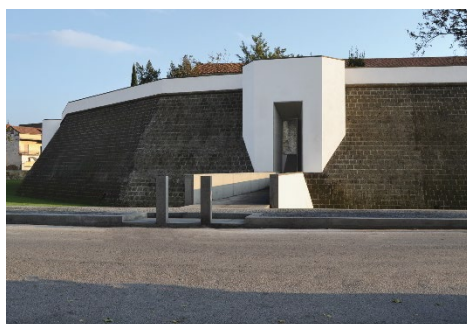
Fig. 9- L'accesso al Castello Baronale di Acerra dopo gli interventi di restauro (Paolo Giordano, 2012).
