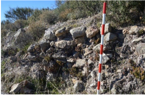
Fig. 2- Restos del derrumbe de la muralla (UE 02) (Autoría propia).
