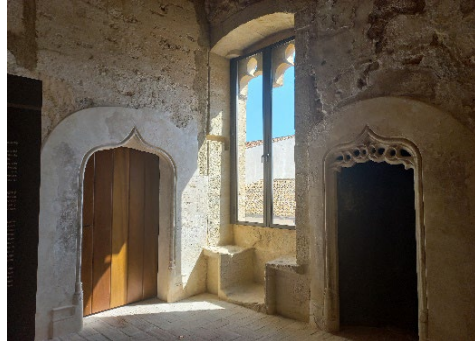
Fig. 11- A la izquierda de la imagen puerta de paso adornada con baquetón y arco conopial. A la derecha se observa el arco conopial con tracería calada. Entre ambas se encuentra la ventana aljimezada con «festejador» (Concepción López, 2024).
