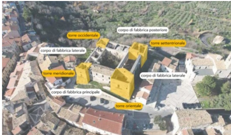
Fig. 5- Vista aerea del castello Caracciolo con indicazione degli elementi principali.
