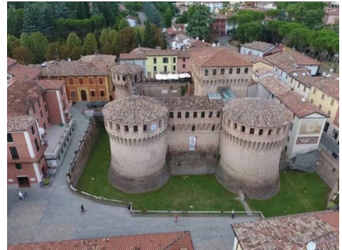
Fig. 5- Vista aerea della Rocca di Riolo Terme a restauro completato (Fonte: Rocca di Riolo Terme, Rocca Sforzesca www.caterinasforza.it ).
