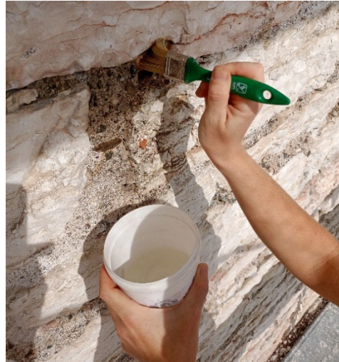
Fig. 7- Consolidamento della malta originale (M. Mazzocchi, 2023)
