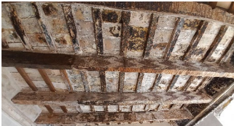
Fig. 8- Forjado con viguetas policromadas y tablero de cerámica en el palacio de Llutxent (Concepción López, 2024).
