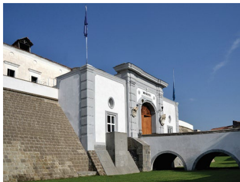
Fig. 5- Il fossato del Castello Baronale di Acerra dopo gli interventi di restauro (Paolo Giordano, 2012).
