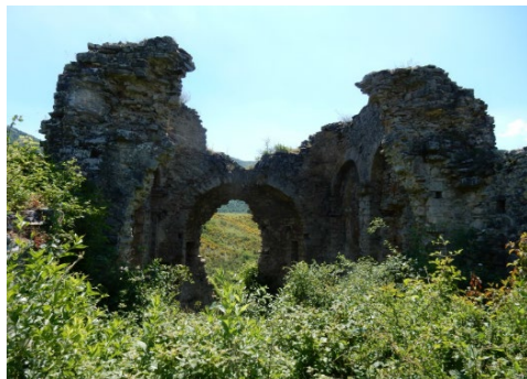
Fig. 5- Veduta complessiva dell'edificio con abside rispettivamente da SE e dettaglio dell'interno della chiesa: caratteristiche architettoniche e tecnica edilizia dei muri della navata e dell'abside che è parzialmente crollata sul fondo (Maurizio Lazzari, 2017).
