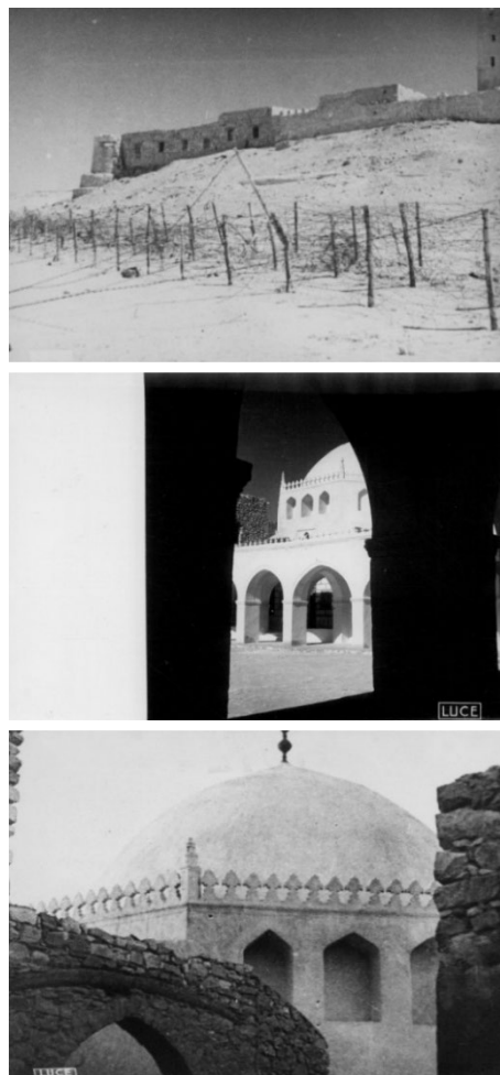
Fig. 4 - Vedute di Giarabùb nell'estate 1942. Mura esterne dal lato settentrionale, mausoleo di Muhàmmad bin 'Alī al-Sanūsī e particolare della cupola (Su concessione del Ministero della Cultura, Com. n° 3967/2024. Archivio Centrale dello Stato, Partito Nazionale Fascista - PNF, Ufficio propaganda, Seconda guerra mondiale, Fronte Africa settentrionale, fotografie Istituto Luce, busta 60, nn. 47662, 47673, 48779).
