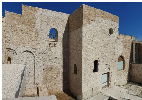
Fig. 10- Bari, Santa Scolastica: porzioni di murature medievali del monastero inglobate nella fortificazione cinquecentesca.
