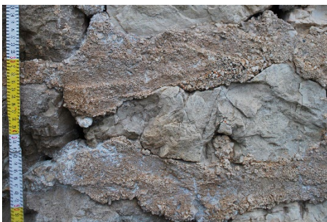
Fig. 3- Castel San Pietro (Vigo di Ton). Mastio, lisciatura, datata XIII secolo (foto di Isabella Zamboni, 2010).
