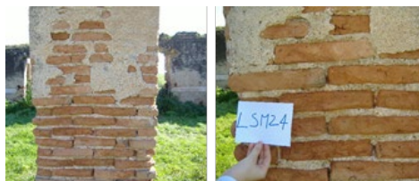
Fig. 7- Prelievo campione di laterizio (foto degli autori, 2024).
