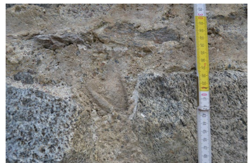
Fig. 4- Castello di Ossana, impronta di cazzuola in fase con la muratura originaria del nucleo I, prospetto esterno nord (foto di Isabella Zamboni, 2012).
