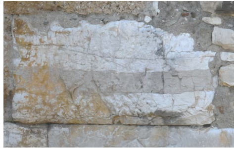
Fig. 11- Dettagli di inclusioni ovoidali e cilindrico-ovoidali riferibili a materiali allojeni rimasti inglobati nel processo di litizzazione (foto dell’autore, 2024).
