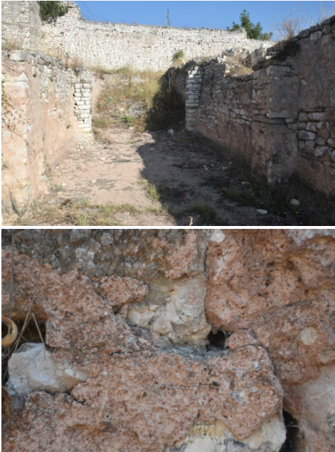
Fig. 8- Lacerti di cocciopesto superstiti in corrispondenza delle cosiddette polveriere sul lato meridionale della piazza d'armi della fortificazione interna (foto dell'autore, 2024).
