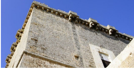
Fig. 4- Torre S.M dell'Alto: angolo ovest (foto di F. Giuri, 2024).
