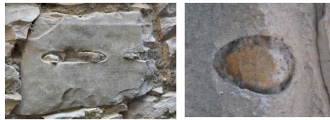
Fig. 11- Dettagli di inclusioni ovoidali e cilindrico-ovoidali riferibili a materiali allojeni rimasti inglobati nel processo di litizzazione (foto dell’autore, 2024).
