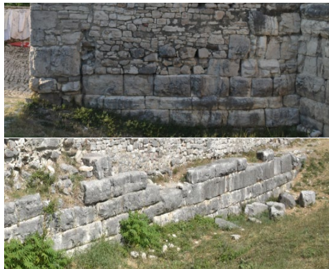
Fig. 1- Emergenze delle fasi antiche ancora "in posto"; Attacco a terra del barbacane della porta principale, fronte interno, lato destro (foto dell'autore, 2024).
