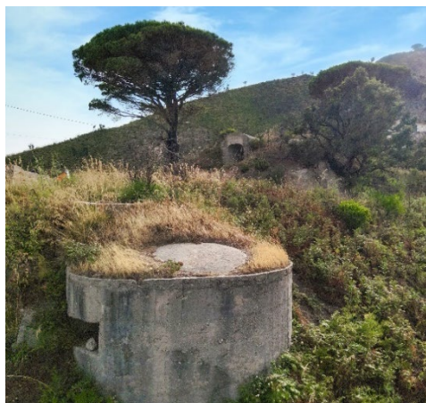
Fig. 4- Vista aerea di dettaglio di uno dei bunker monoarma appartenenti al raggruppamento in località Campo Italia, a presidio dell'accesso sud del Forte Masotto (foto degli autori, 2024).
