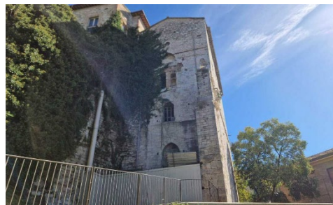
Fig. 2- Facciata anteriore della chiesa (Gasperini, 2024).
