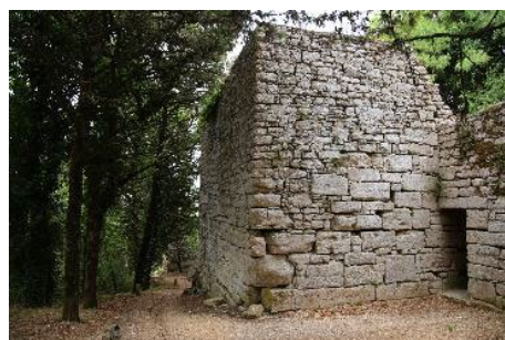
Fig. 4- Vista di una delle torri che costituiva il sistema difensivo occidentale (foto dal sito web FAI, i luoghi del cuore, 2020).
