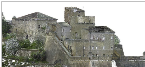
Fig. 4- Nuvola di punti di Forte San Giovanni (elaborazione grafica a cura di Fabrica srl, 2022).
