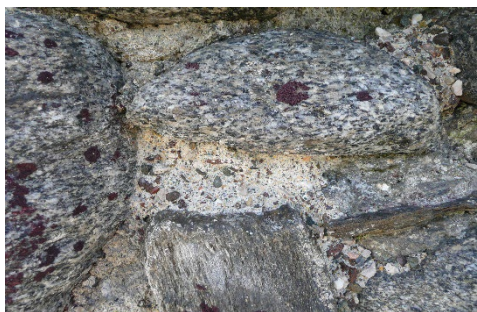
Fig. 14- Castello di Ossana. Composizione della malta di restauro (foto di Isabella Zamboni, 2010)
