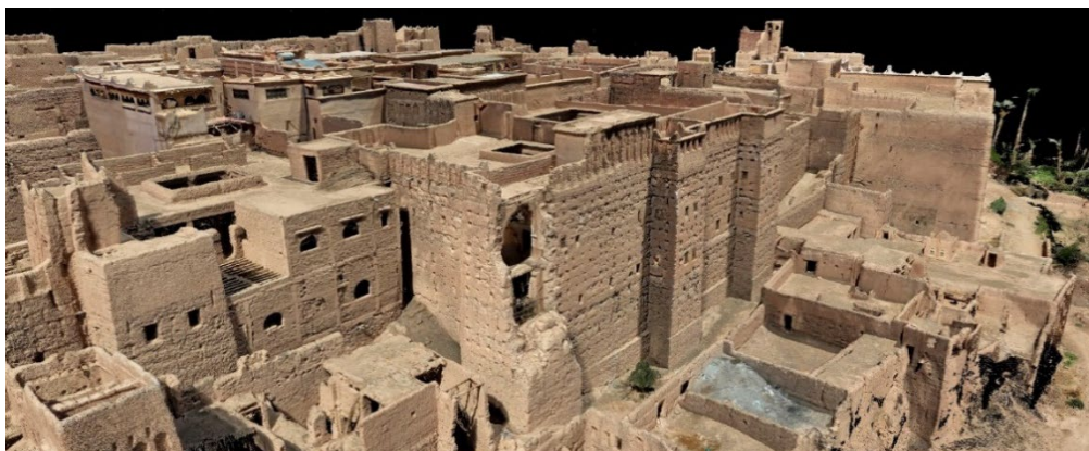
Fig. 7- Nuvola di punti complessiva dello Ksar di Tamnougalt: oltre alle caratteristiche morfometriche è possibile apprezzare le peculiarità materiche delle strutture in terra cruda (elaborazione degli autori, 2024).
