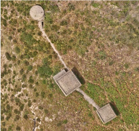
Fig. 5- Vista aerea del raggruppamento di bunker monoarma collocati lungo la SP 44, in località Campo Italia, a presidio dell'accesso sud del Forte Masotto. Coordinate 38°14'34.0"N 15°33'12.3"E (foto degli autori, 2024).
