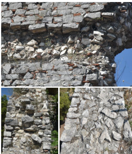
Fig. 5- Prospetto “sfogliato”, sezione verticale ed orizzontale residuali delle murature a sacco (in posizioni differenti) (foto dell'autore, 2024).
