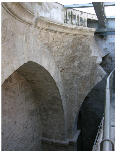
Fig. 5- Bari, Fortino di S. Antonio: resti della campata centrale della chiesa con la cornice su cui si impostava la cupola.
