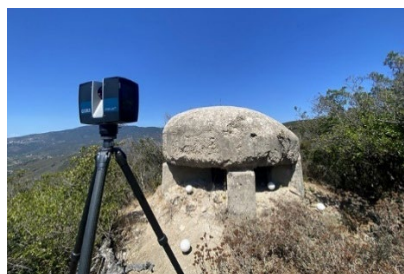
Fig. 4- Immagine scattata durante un rilievo di una postazione per mitragliatrice in località "Monumento", Monte Cocchero in calcestruzzo armato (foto degli autori, 2024).
