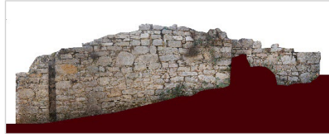
Fig. 7- Ortofoto del fronte Sud-Est del varco di ingresso.
