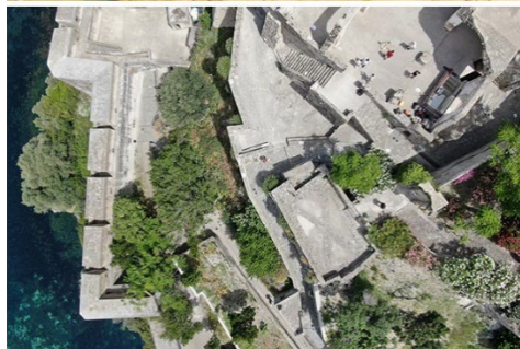
Fig. 3- Confronto tra la cartografia del Tortelli e lo stato attuale dell'area oggetto di studio.
