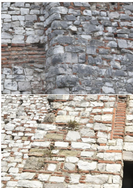
Fig. 6- Seconda murazione della porta principale, porzioni murarie della piazza d'armi interna in opera vittata, listata o vittata riquadrata (foto dell'autore, 2024).
