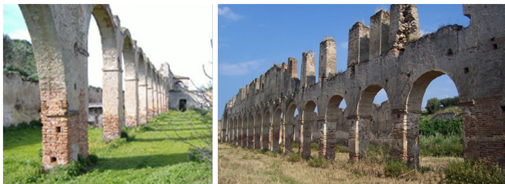
Fig. 4- Strutture ad arco in laterizi (foto degli autori, 2024).
