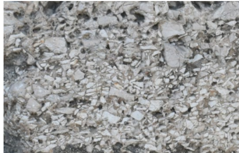
Fig. 12- Dettagli di blocchi in pietra calcarea sedimentaria ed in marne calcaree (foto dell’autore, 2024).
