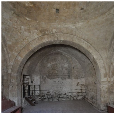
Fig. 13- Monopoli, Chiesa di San Nicola de Pinna: parete absidale.
