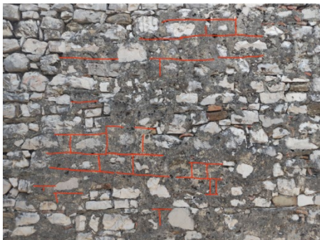
Fig. 13- Dettagli degli intonaci rasopietracon “graffiture” a richiamare un’opera pseudo-isodoma sulle mura ottomane della cattedrale-museo “fjetja s Shen Merise” (foto dell’autore, 2024).
