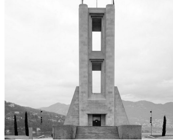
MONUMENT TO THE FALLEN, COMO (1931)
